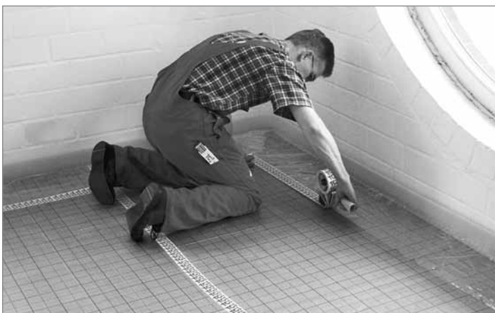
Уплотнение краевых изоляционных полос
