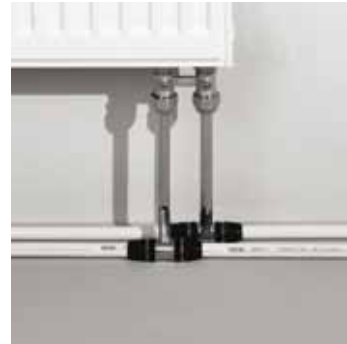
Подключение радиатора с использованием проходной трубки
