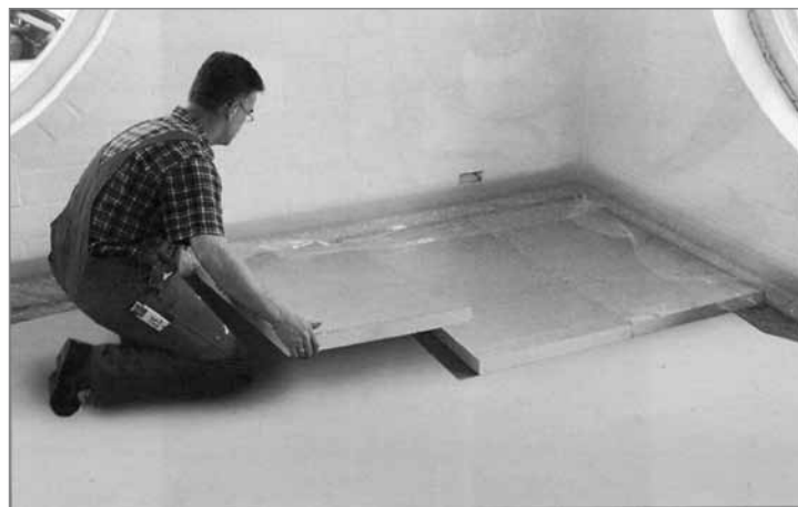
Укладка изоляции PUR
