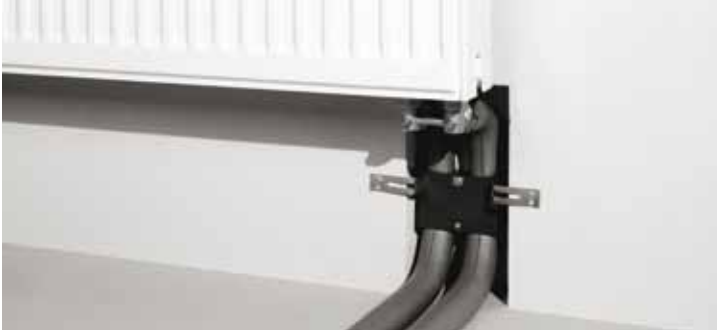
Подключение радиатора с использованием настенного монтажного узла
