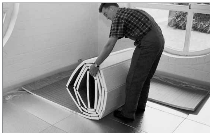
Укладка рулонной изоляции
