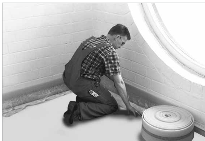
Укладка демпферной ленты
