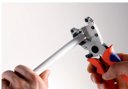
Обрезание трубы при помощи труборезных ножниц
