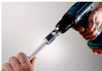
Калибровка и снятие фаски
