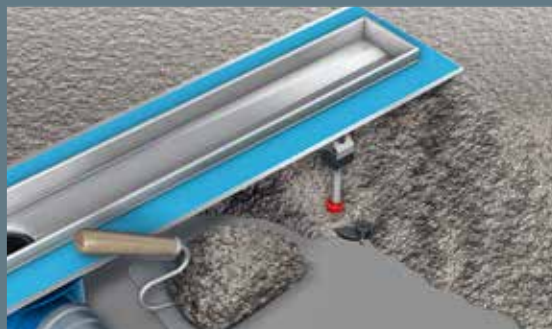
Шаг 2 - Укладка бетонной стяжки
