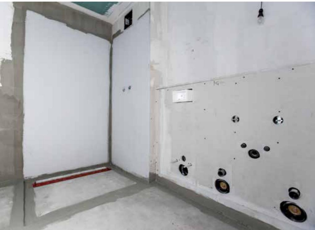
Объект готов к облицовке плиткой. После обшивки панелями регистры можно облицовывать плиткой. Слева виден дренажный канал для душевой TECEdrainline с красной уплотнительной лентой Seal System.
