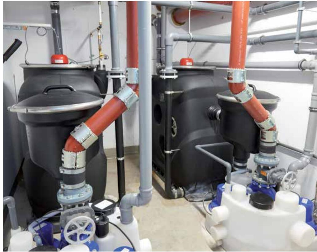
Благодаря небольшим размерам корпуса основы, в узком пространстве подвала помещаются также жироотделители.
