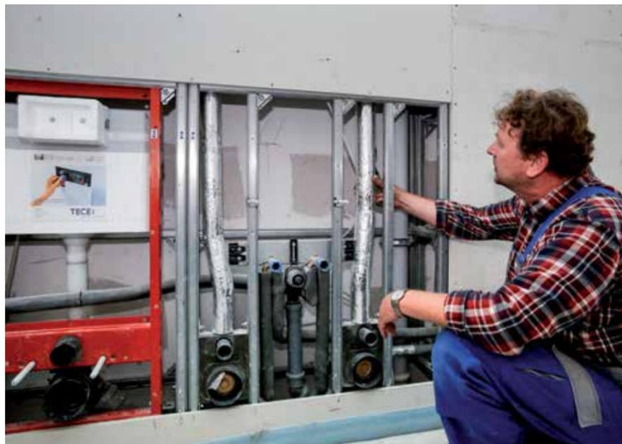
Бернд Эстерлинг, контролирующий слесарь-монтажник из TGS GmbH, осматривает соединения. Затем регистры обшиваются гипсокартоном.
