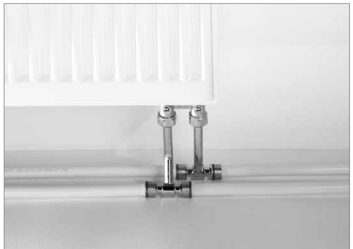
Подключение радиатора с использованием монтажного тройника
