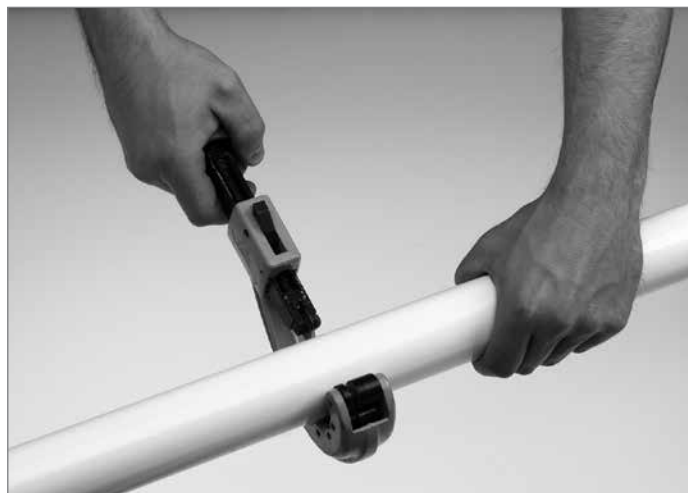
Труба обрезается с помощью трубореза (арт. 876 00 08). Труборез оснащен специальным отрезным кругом для пластика
