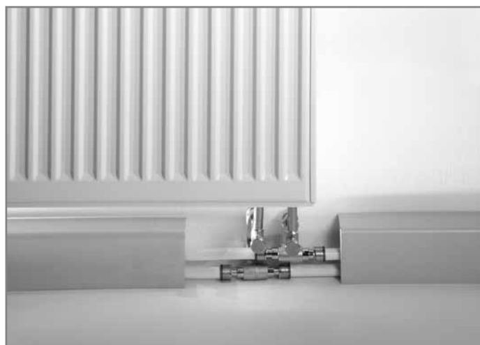
Подключение радиатора из плинтуса
