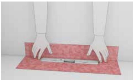
**Шаг 4:** Герметизация с щелчком: после установки стяжки гидроизоляционную манжету Seal System нужно вдавить в желобок.
