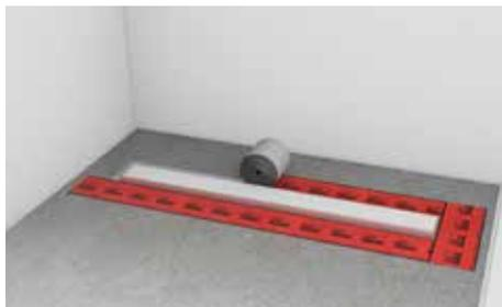
**Шаг 3:** Гидроизоляционная лента наклеивается таким образом, чтобы она перекрывала фланец душевого канала и стяжку.
