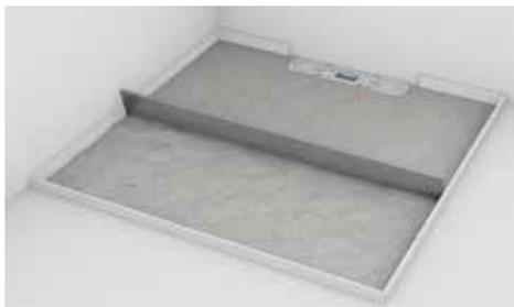
**Шаг 3:** Стяжка устанавливается с уклоном от 1 до 2% к стене. Заводская установка защищает слив от повреждений и грязи в процессе работы.
