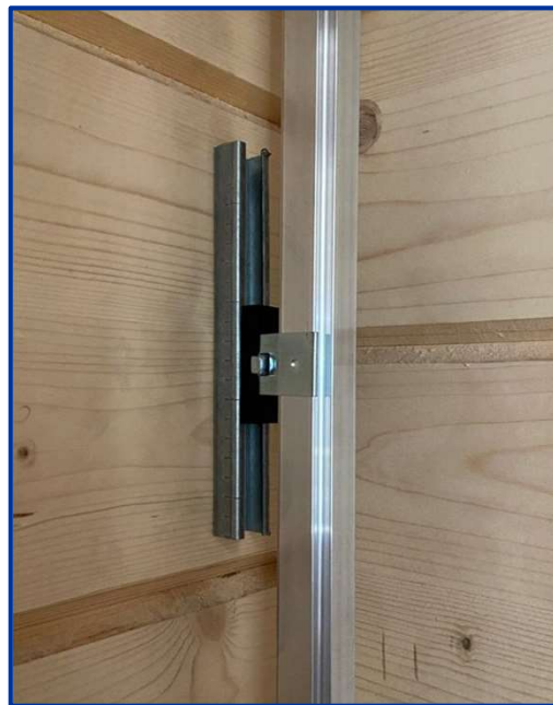
Пример установки скользящих опор WB90123 на объекте
