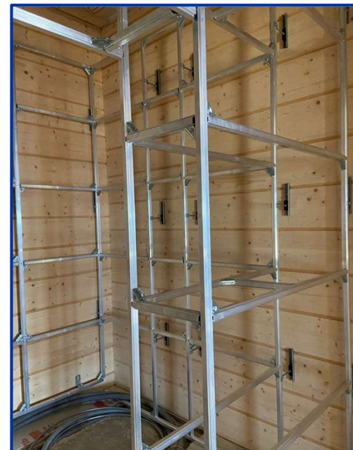
Пример установки скользящих опор WB90123 на объекте
