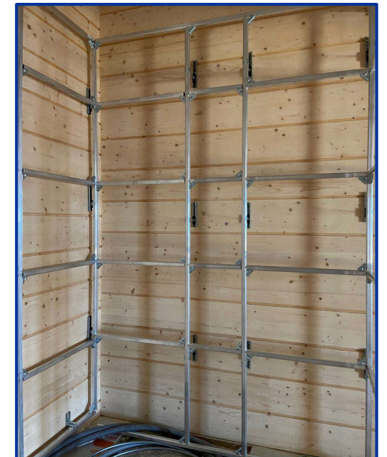
Пример установки скользящих опор WB90123 на объекте
